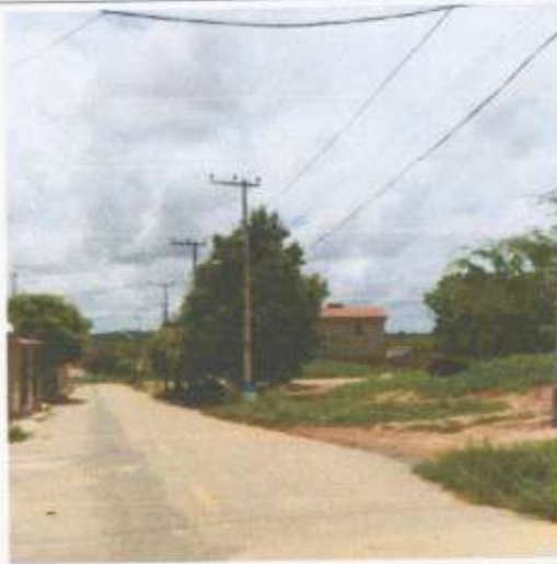
Foto 1 - Via e calçadas
