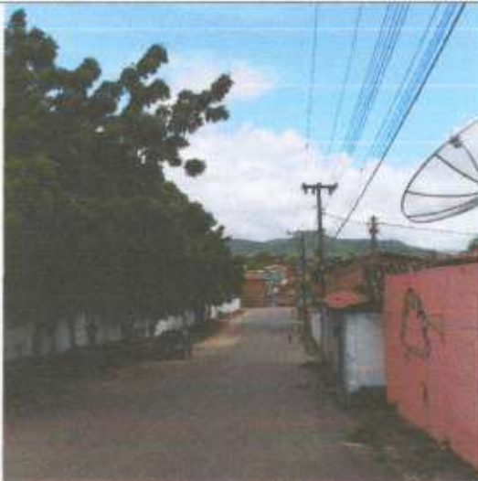
Foto 1 – Via e calçadas
